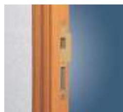
Con el UC16K y la FR66P es posible realizar el encaje para la armella o cerradero y los orificios del picaporte y palanca.
