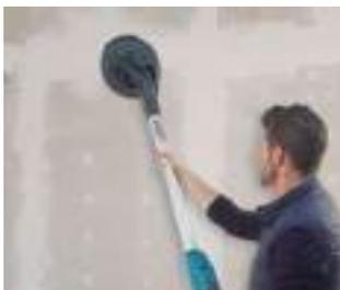
La gran capacidad de extracción de material permite el lijado de estucados o gótese.
